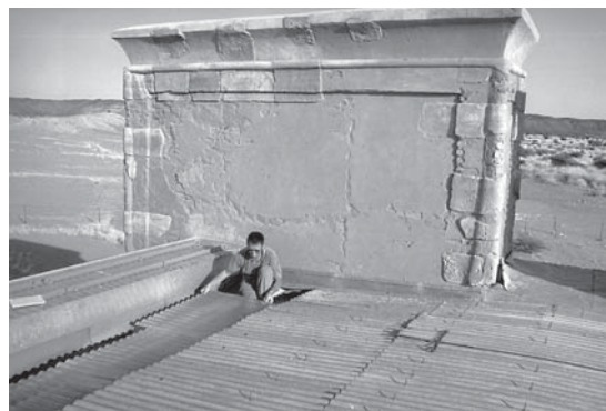
Abb. 9: K. Berbalk beim Verlegen der letzten Platten (Foto: R. Wenig).
