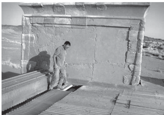
Abb. 8: K. Berbalk beim Verlegen der letzten Platten (Foto: R. Wenig).
