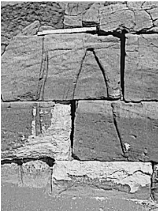
Abb. 1 : Steinzerfall am Relief des Tempels II A
