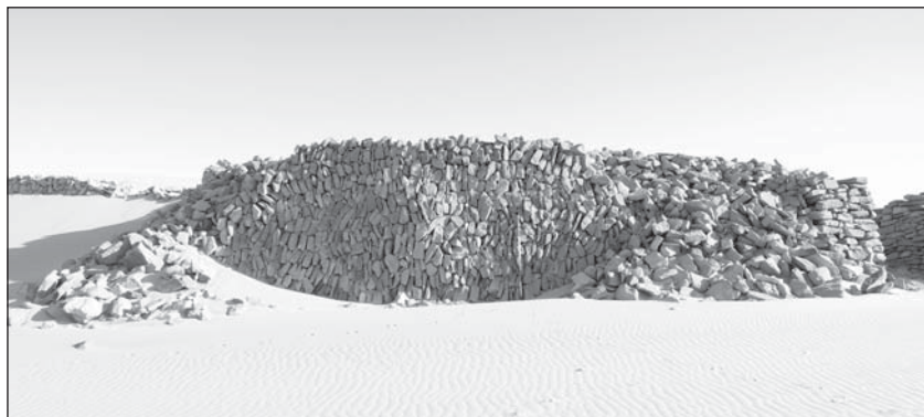
Abb. 9: Aussenschale des Mauerwerks in senkrechter und in horizontaler Lagerung, am Nordtor.
